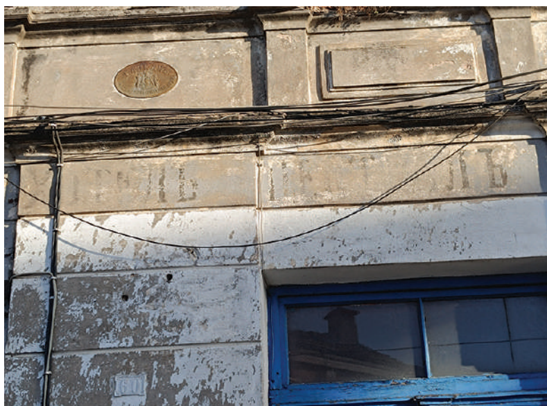
Сн. 6. На фасадата се чете надписа „Хотелъ Централъ“ и е запазена монтираната метална плочка, на която пише „Народно осигурително дружество Балканъ“. Сн. С. Антова, 2023 г.
