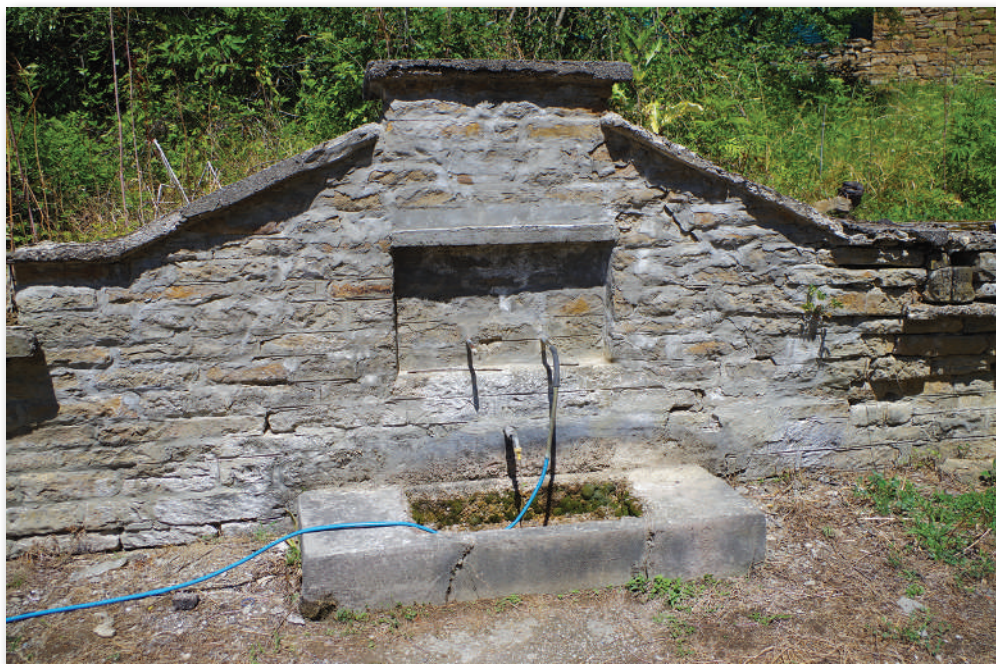
Ил. 3. Отвеждане на вода от преливната тръба на чеима с канелка, юли 2025 г. Сн. Петър Петров
